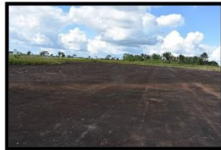
Visão geral do pátio de estacionamento de aeronaves.
