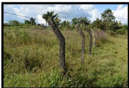
Figura 1: Fotografia da cerca próxima da pista de pouso e decolagem.
