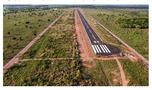
Em altitude de 961 pés, o aeródromo (SSCI) tem pista (02/20) de 23 x 1.300 m., de asfalto, com resistência de pavimento PCN 13 e resistência de subleito alta. O aeródromo tem homologação para operação VFR diurna.
