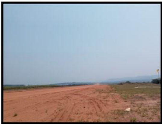
Figura 21: Fotografia com visão geral da faixa de pista, lateral direita.
