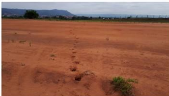
Figura 3: Rastro de animal de grande porte na superfície da Pista de Pouso e decolagem.
