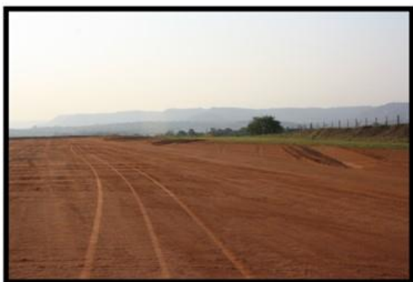
Figura 11: Visão geral do sistema de drenagem.
