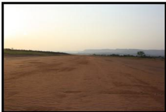
Figura 7: Visão geral da pista de pouso e decolagem (PPD).
