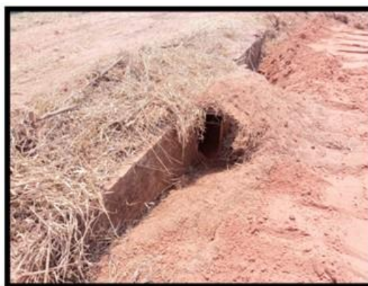
Figura 12: Fotografia com "close" em uma vala ou outro elemento do sistema de drenagem.
