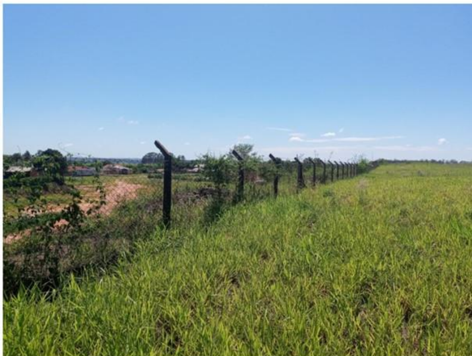
Fig 7. – Acesso para patrulhamento limite leste (item 12)
