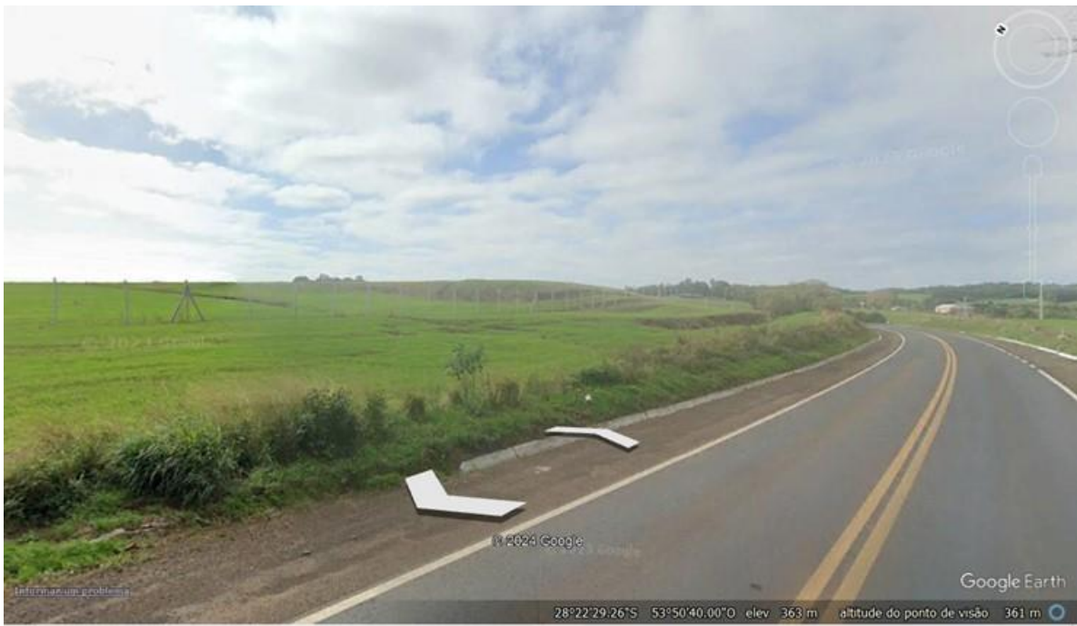
Vista da BR-285 – sentido de Ijuí para Carazinho/RS (a leste)
