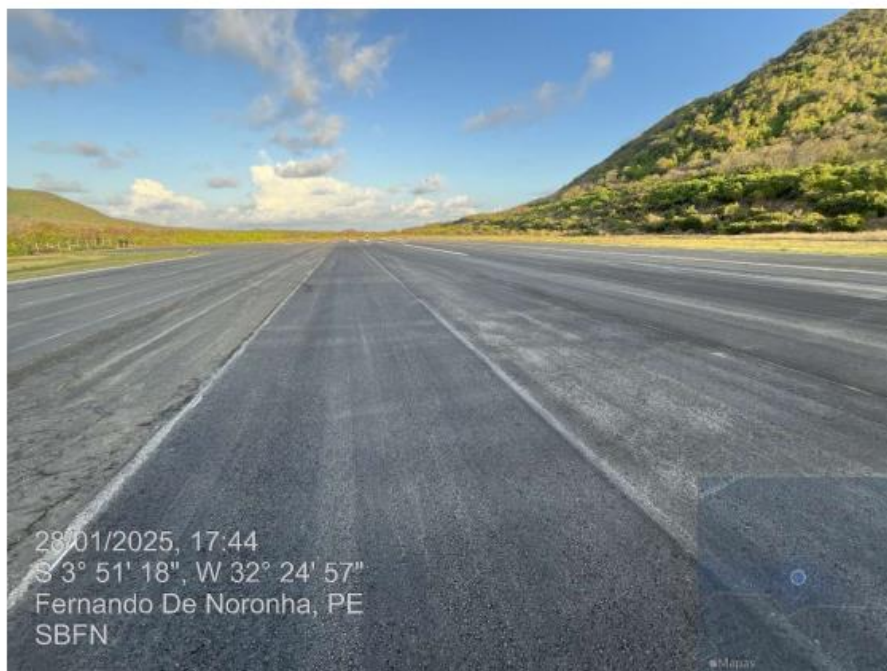
Foto 12 – Área de pavimento recuperado x área de pavimento não recuperado
