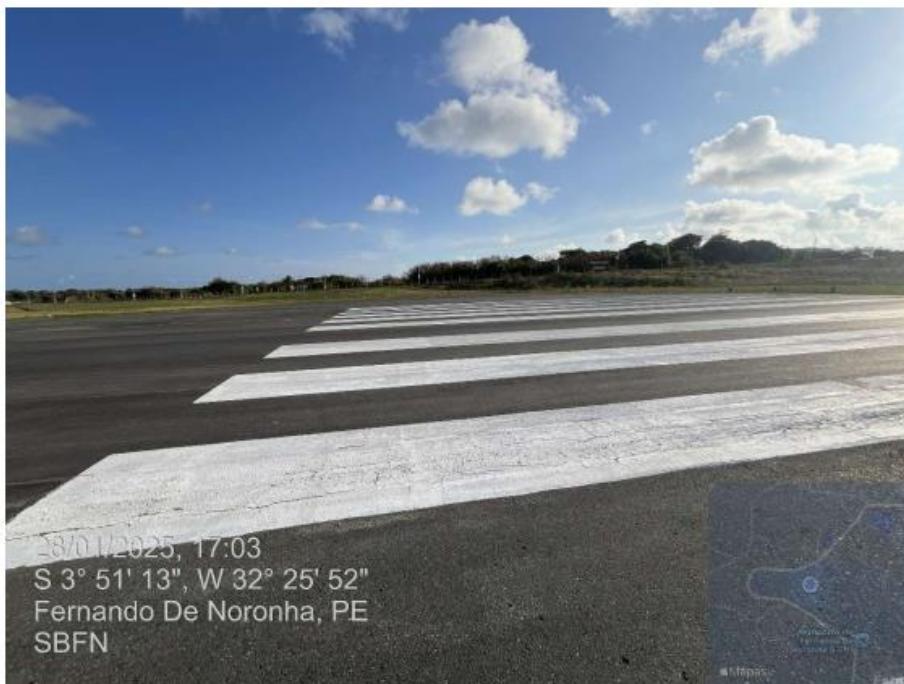
Foto 2 – Sinalização horizontal da cabeceira 12
