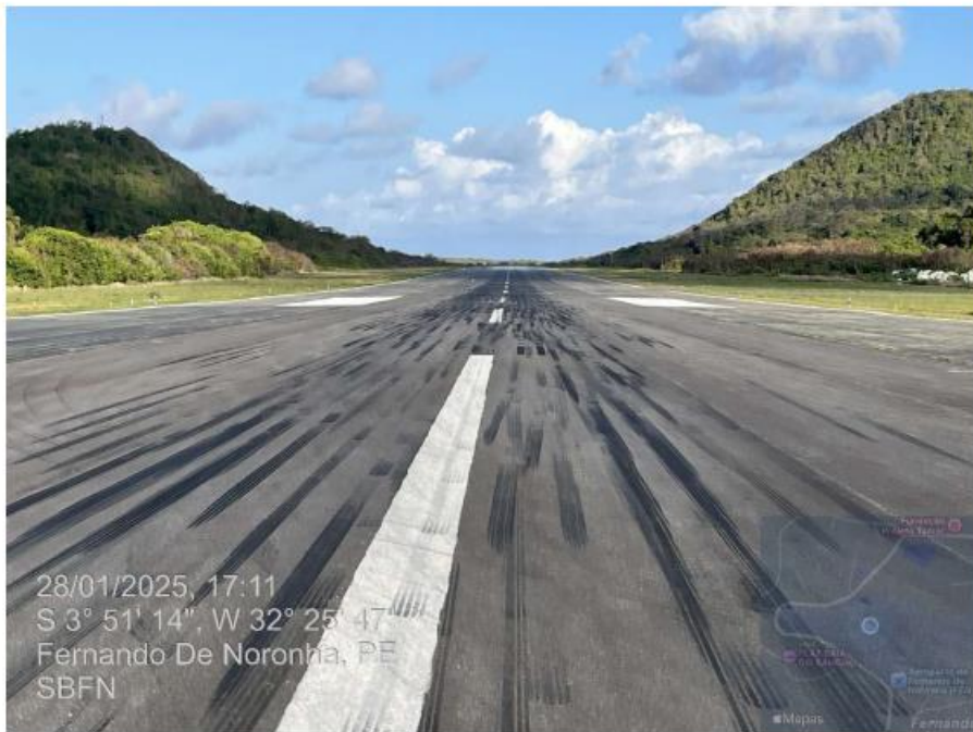
Foto 6 – sinalização de eixo de pista
