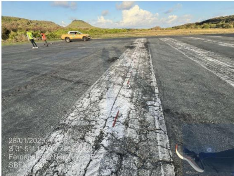
Foto 15 – Sinalização horizontal da cabeceira 30
